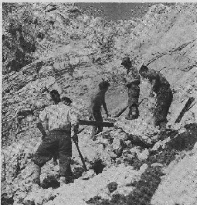
Udarniki pripravljajo temelj za bivak
