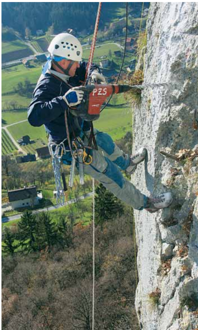
Zahtevno delo pri gradnji poti FOTO: MIJO KOVAČEVIČ
