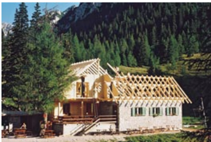
Začetek gradnje kočje na Zelenici
