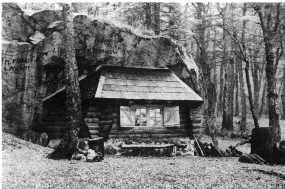
Zavetišče Pod skalco, poimenovano po Robertu Petričku; na mestu stare kočice so ga zgradili poleti 1977/78
