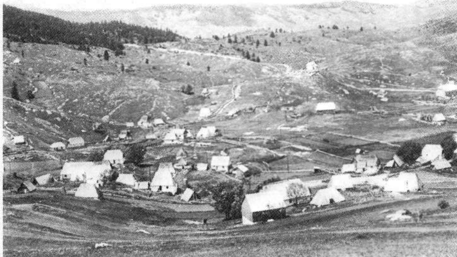
Le redko naletiš na kak zaselek
