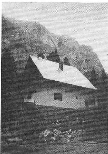
Koča na Gozdu v gradnji.
