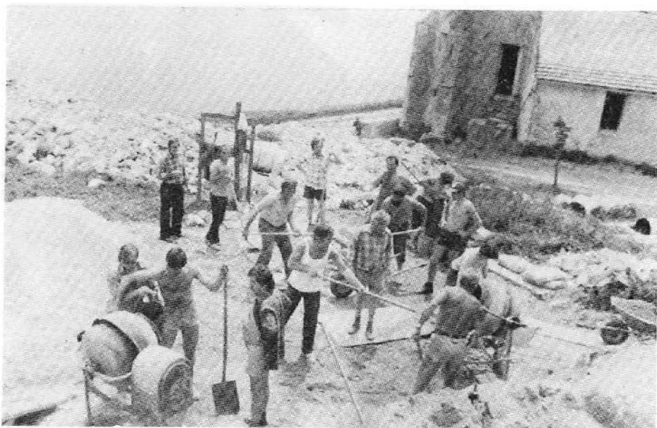
Betoniranje plošče 22. 7. 1981 na Uršlji gori
