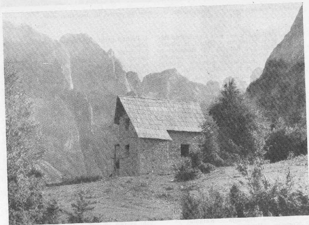
Planinska koča v dolini Grbaje med gradnjo
