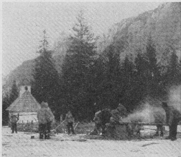
Prstovoljno delo v Tamarju: Smoljenje vodovodnih cev
