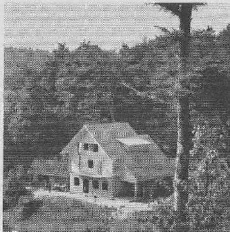
Planinska koča na Bohorju (v gradnji)
