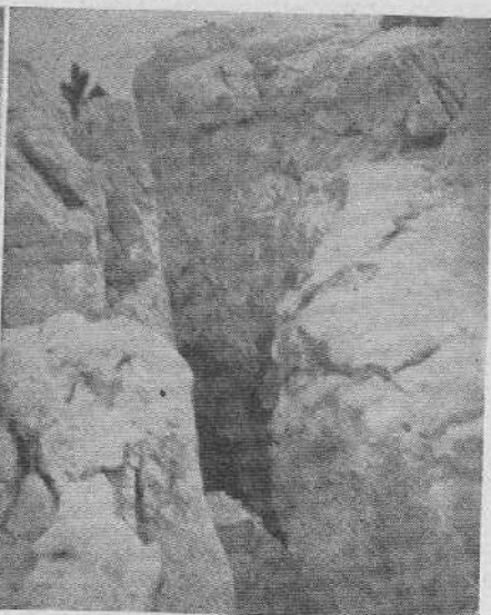
Sl. 5. Razpoka v apnencu nad Korošico
