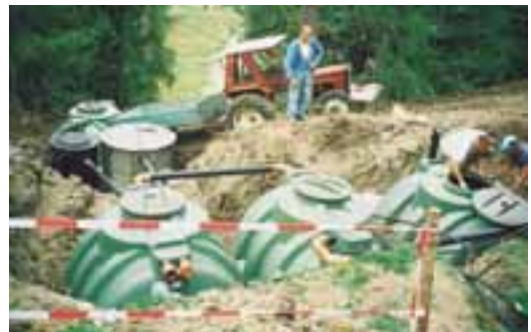
Montaža čistilne naprave (foto: Danilo Sbrizaj)
